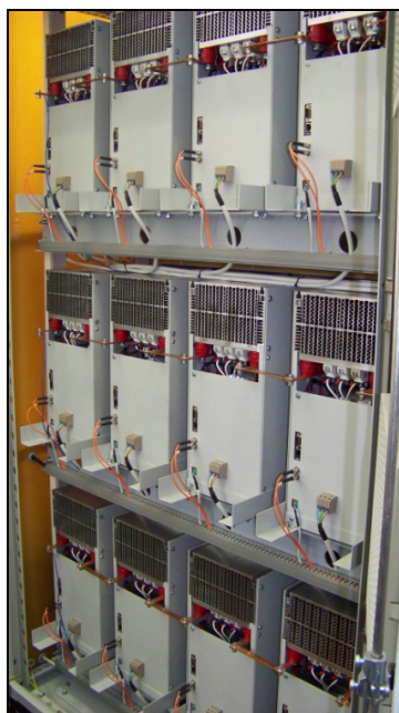
Рис. ПЗ.4. Внешний вид секции управляющего контроллера ( a ) и секции силовых ячеек ( б )
