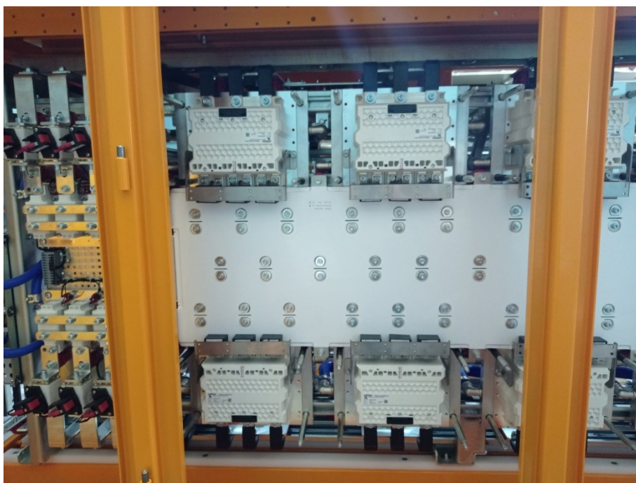
Рис. 1. Конструкция ШПСУ с общей шиной DC
